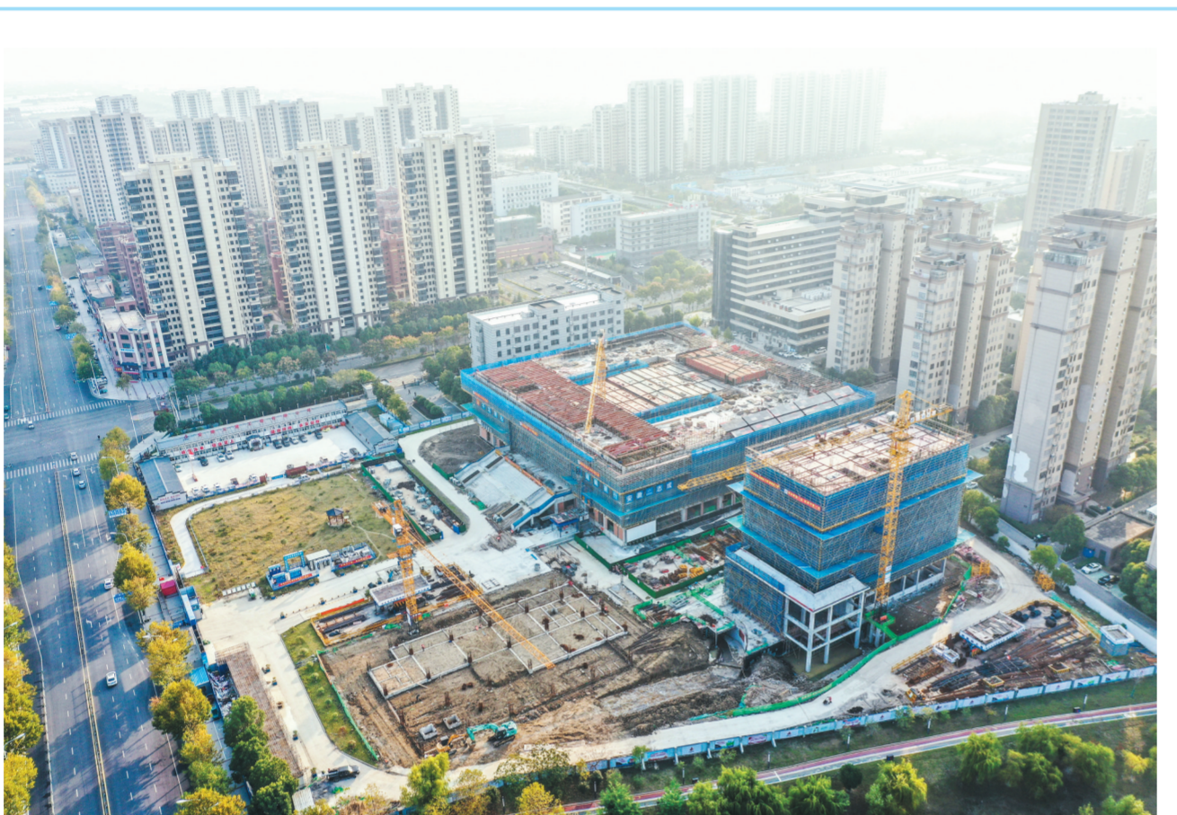
县委党校改扩建项目公寓楼已完成八层主体结构施工,即将进入墙体砌筑阶段,学术报告厅屋面三根型钢梁吊装工作已完成,主体结构即将封顶,整个工程已完成合同目标的60%。
