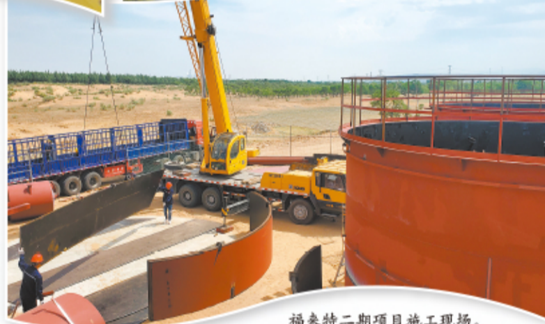
福来特二期项目施工现场。
