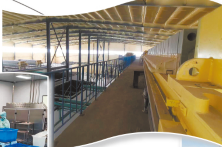
内蒙古弘和膨润土加工有限公司新建50000t超纯石英材料项目压滤机车间。
