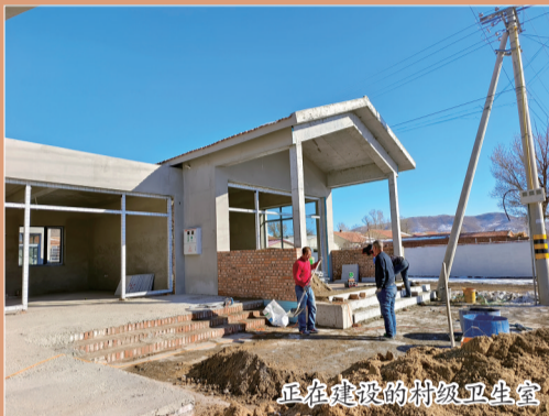
正在建设的村级卫生室
