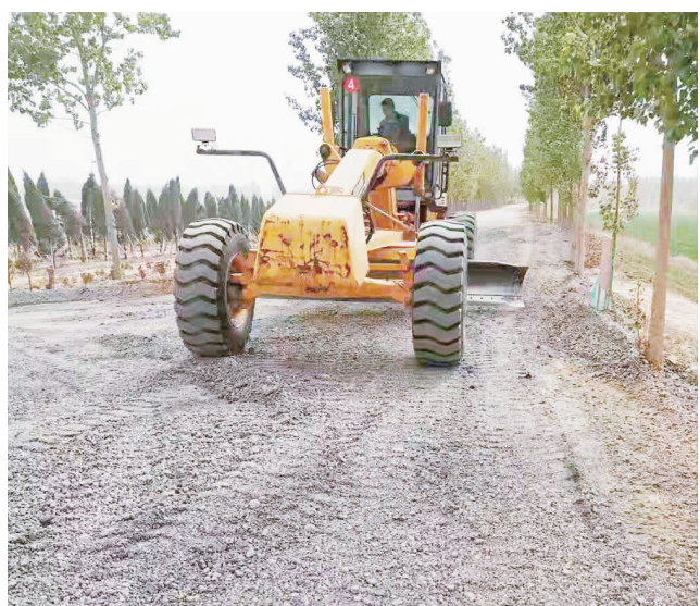
黄河涯大桥西侧大堤路面铺设洗刨料
