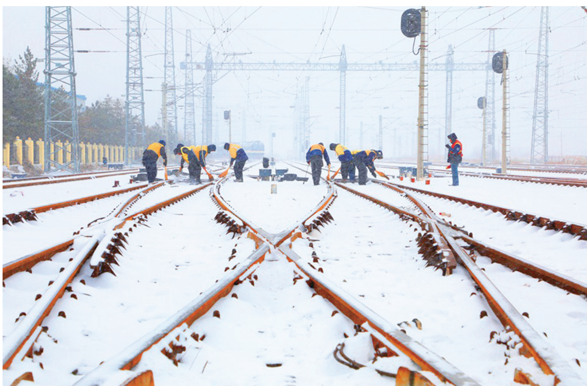
受东北冷涡及地面气旋强烈发展影响,11月6日以来,辽宁、吉林、内蒙多地出现雨雪寒潮天气,内蒙古东部地区积雪深度达到22厘米。中国铁路沈阳局集团有限公司19万干部职工积极投入到线路道岔除冰融雪,保障运输秩序,确保旅客安全乘降等重点工作当中。
