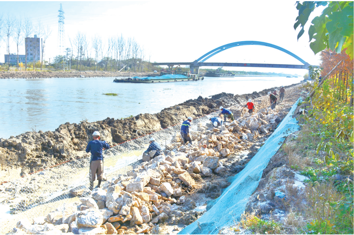
11月24日,连申线盐城段五期护岸工程施工现场,工作人员正在抢工会战,全力推进建设任务。该工程总投资5000万元,是江苏省今年投资额最大的航道养护项目,计划12月底竣工。
