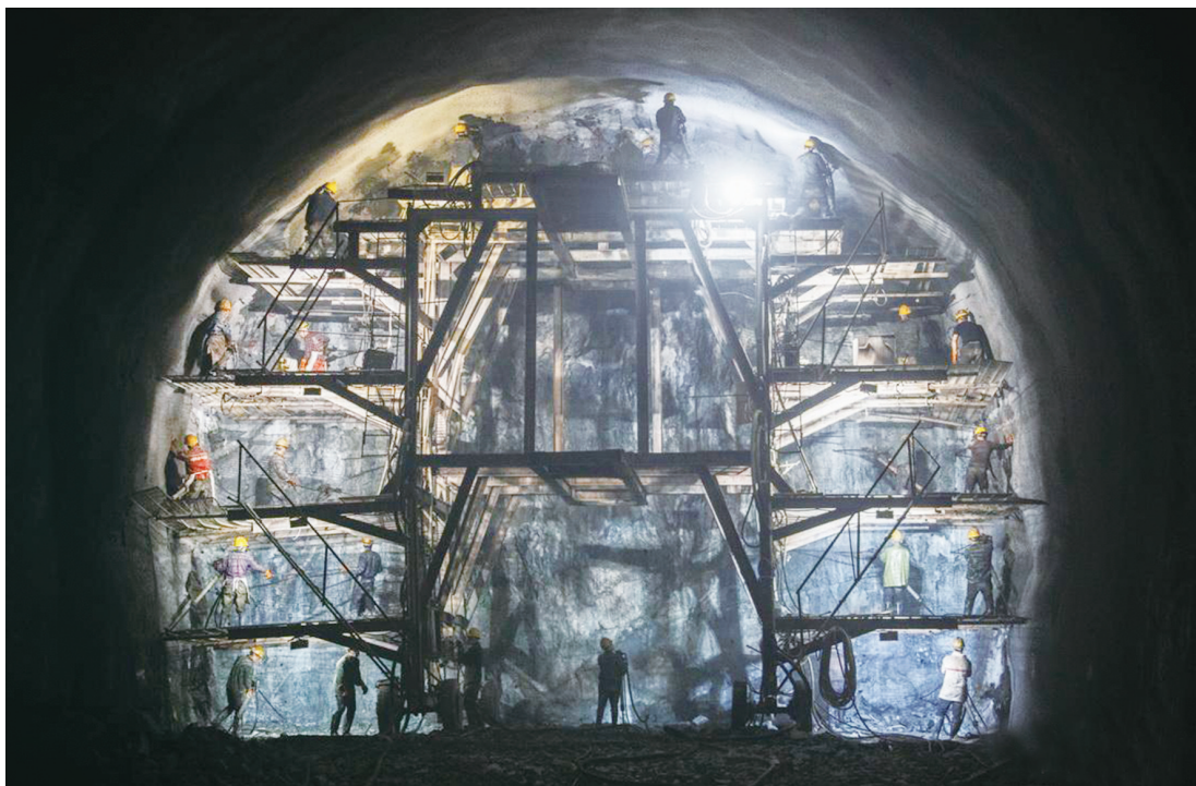
12月14日,昌景黄铁路安徽段施工建设迎来重要节点,超6公里长大隧道云头山隧道顺利贯通,标志着标段内最后一处高风险控制性工程顺利完成,为明年全线实现通车运营奠定了基础。
