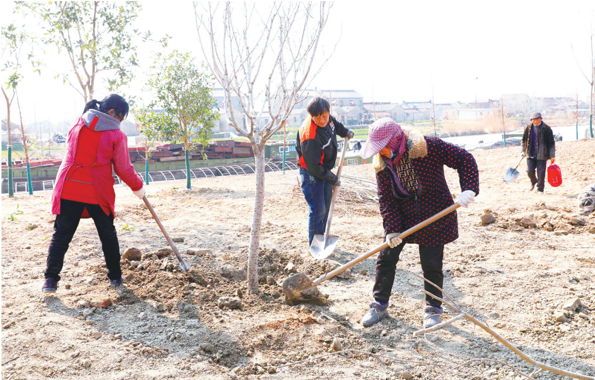
2月21日，白驹镇三十里河闸边，工人们在建设中的河滨公园平整坡地、栽植绿化，一派热火朝天的景象。该镇狠抓沟河池塘水环境整治，大搞水利绿化，在各类滨河、临水地带建设“口袋公园”，既提升了农村人居环境，又方便了附近群众健身休闲娱乐。 卞旭辉 董汝涛 摄
