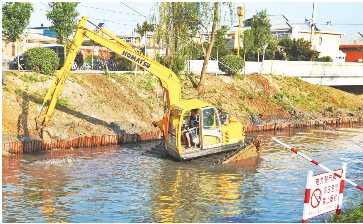
8月31日,在草堰镇三元村二十五总河,工作人员操作挖掘机进行河坡刷新整治。近年来,该镇突出水环境保护、岸线管理,不断提升水环境,今年已完成七里港河等4条高标准生态河道建设,高质量整治12条村庄河塘,实现水清、岸绿、景美。 周汉明 摄
