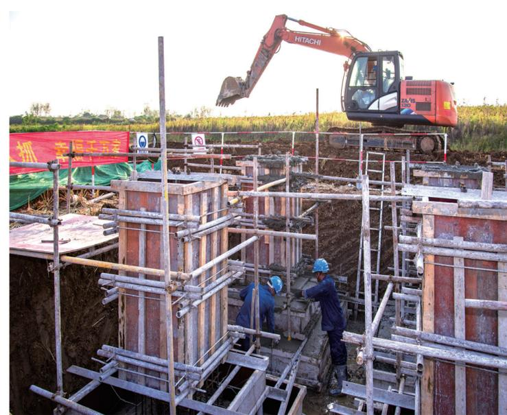
10月9日，在桑园镇青春村刚刚收割过的稻田里，县供电公司施工人员正在进行电力线路角钢塔基础施工，这是新建35千伏漆藕线的第24号角钢塔基础。新建35千伏漆藕线工程计划于明年7月竣工，届时藕塘、大桥等乡镇的供电可靠性将大幅提升，将有利于促进该区域的乡村振兴。
