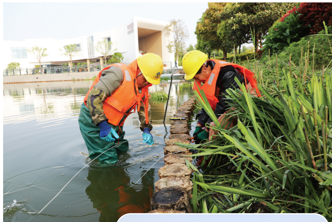
4月22日，白天鹅公园，工人正在对湖堤进行加固，施工现场一片忙碌景象。白天鹅公园湖堤长年受到湖水浸泡和水浪的侵蚀，已部分塌入湖内，为消除该安全隐患，我县实施县城南城区调蓄设施建设工程——白天鹅公园湖堤加固。
