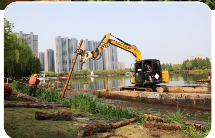
4月22日，白天鹅公园，工人正在对湖堤进行加固，施工现场一片忙碌景象。白天鹅公园湖堤长年受到湖水浸泡和水浪的侵蚀，已部分塌入湖内，为消除该安全隐患，我县实施县城南城区调蓄设施建设工程——白天鹅公园湖堤加固。
