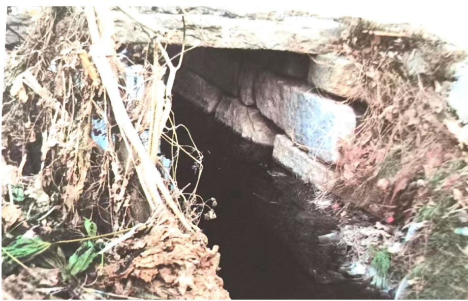
五坝附近石工遗址
