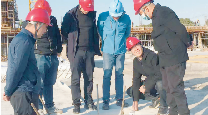
检查中医院项目基础防水层施工质量
