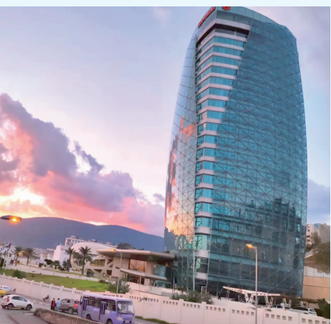
南通涌伦建筑劳务有限公司
