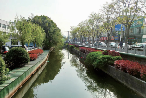
整治后的通沙河(东洲菜场南侧河道)
