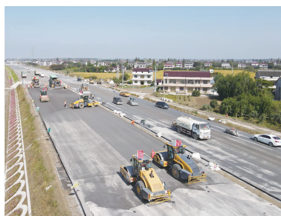
图为施工现场
