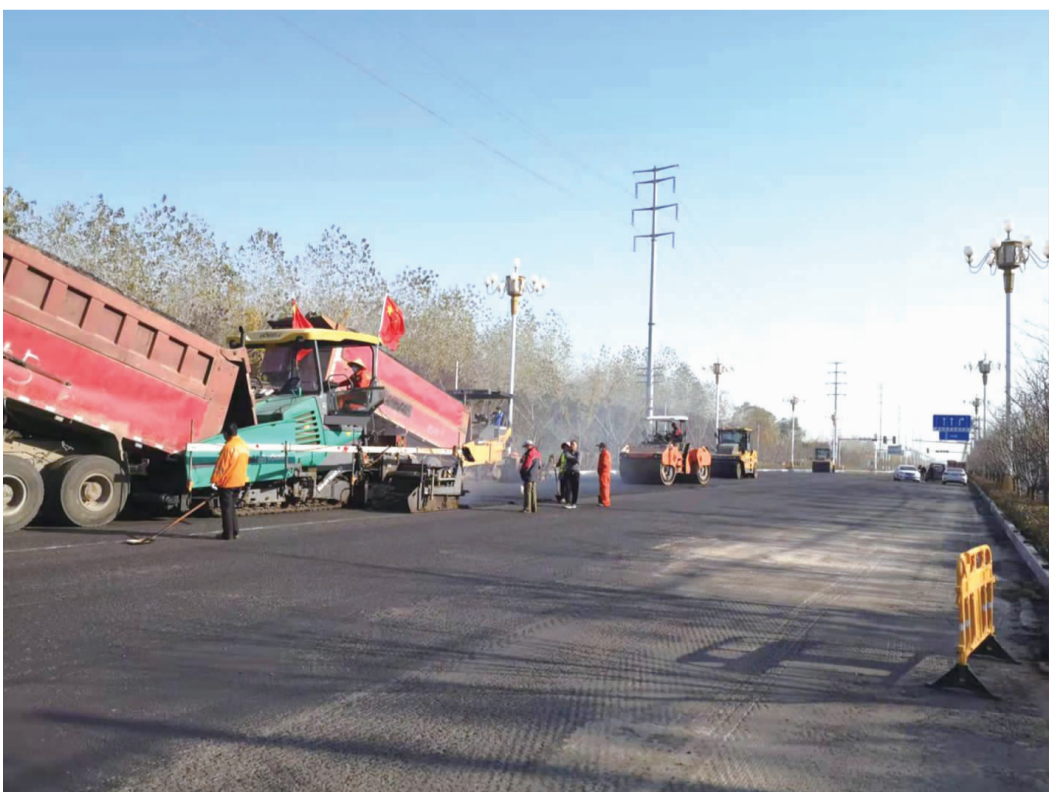
为方便群众出行，自10月底起我区对长江东路进行改造，该项目全长6公里，总投资约4000万元，目前正按序时进度实施中。项目建成后将对提升全区交通形象、方便周边群众出行、促进地方经济发展起着积极作用。
