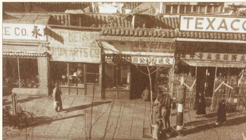
静安寺路1246号-1256号沿街商舖外景
