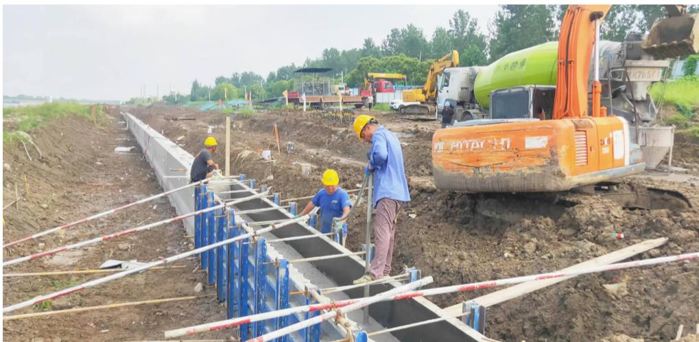
8月15日，记者在位于邵伯镇的京杭运河绿色现代航运综合整治工程江都段施工现场看到，工人汗流浃背，施工现场如火如荼。项目负责人童忠介绍，护岸钻孔灌注桩、钢板桩、管桩与水泥搅拌桩、帽梁、墙身等施工同步进行，江都段整治工程已过半。
