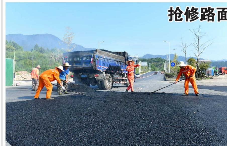
昨日，在汪黄公路黄岱大桥附近，养护工人们冒着酷暑，抢修破损路面。据悉，更楼街道市政抢修服务中心近期组织养护工人对辖区公路破损路面进行修补，确保往返车辆平安出行。
