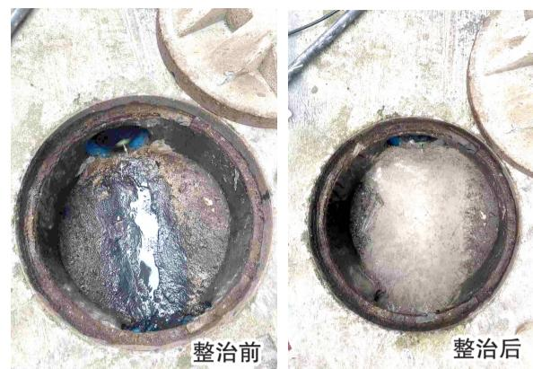
**本报讯** 近日有群众反映，寿昌镇大塘边村有一处污水管网堵塞。寿昌镇“五水共治”办工作人员立即前往现场核实。经了解，该处管网因进水量较大，流槽部分粗糙，导致垃圾沉积，影响出水，影响了农户的正常生活及村庄环境。
