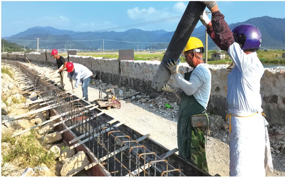
昨日，工人正在越溪红旗塘堤坝除险加固工程现场浇筑坝面加固堤梁。该项目总投资2000余万元，除险加固堤坝总长1465米，除对原坝体加高外，坝顶路面将浇筑沥青，堤坝内护坡进行绿化并种植花卉，预计年底可完工。届时，堤坝在防汛能力进一步提升的同时，也将成为一道靓丽的景观带。（记者 惠广亮 通讯员 章亚丽 摄）
