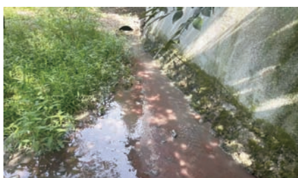
养鸭场旁沟渠废水直排
