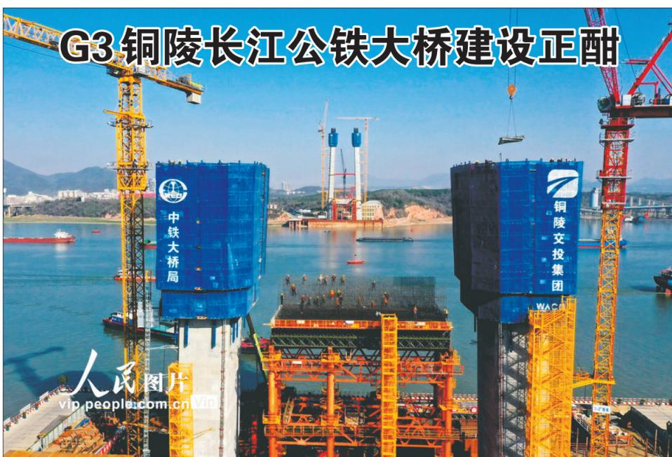
G3铜陵长江公铁大桥为《长江干线过江通道布局规划(2020-2035年)》中规划的过江通道之一。大桥位于现有铜陵长江公路大桥上游约720米处，两端连接G3京台高速，既承担铜陵长江公路大桥替代桥功能，又搭载铁路过江，按照四线铁路、六车道公路标准建设。大桥建成后将对区域经济协调发展、长三角互联互通等产生积极作用。图为3月13日，施工人员在G3铜陵长江公铁大桥进行3号主墩塔柱施工。
