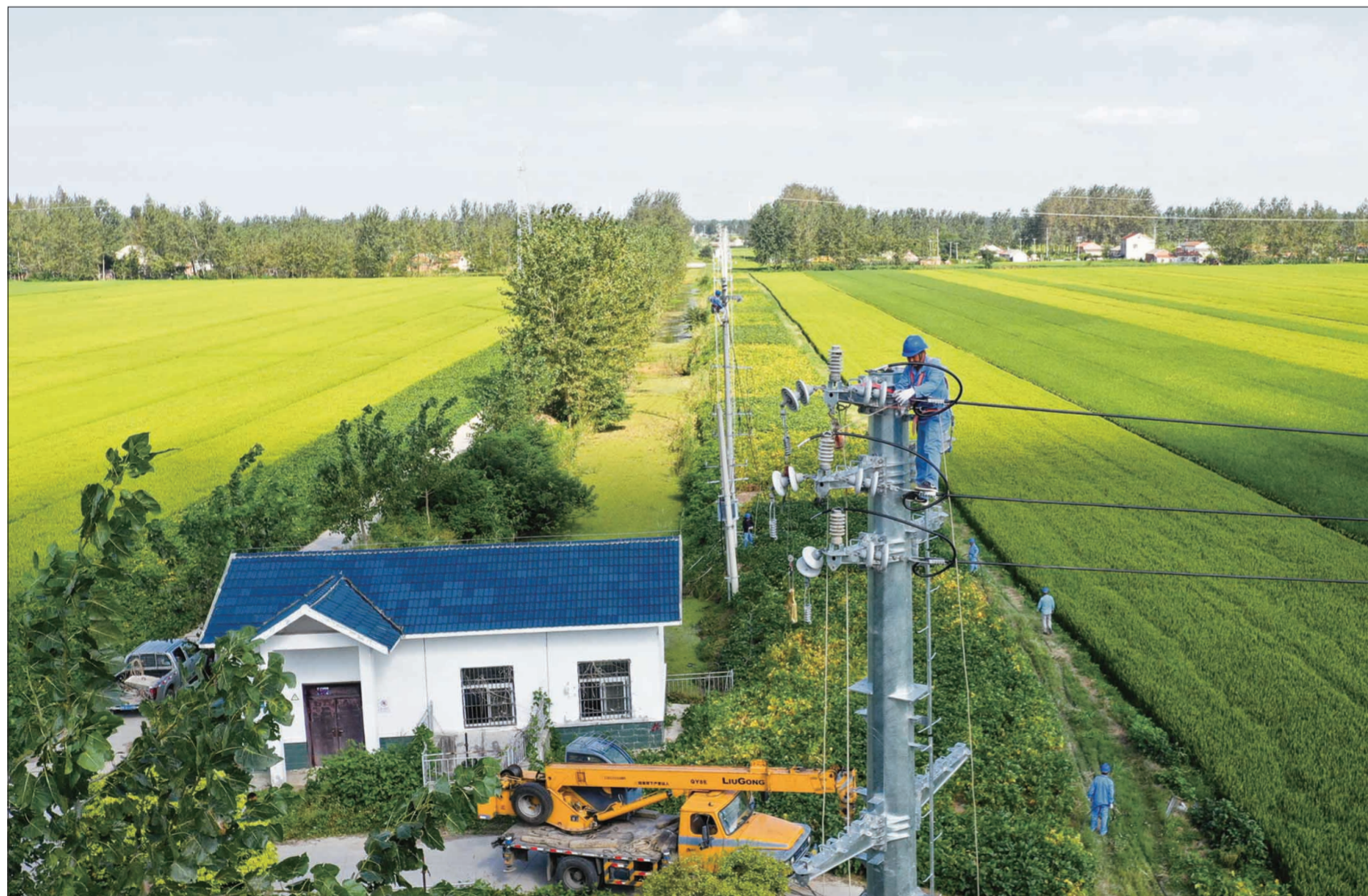
9月16日，国网金湖县供电公司组织对前峰镇境内前峰、白镇两条10千伏线路存在的安全隐患进行集中整治，安装柱上开关6台，更换绝缘导线4千米，移位200千伏配电变压器1台，进一步增强其供电可靠性，惠及1000多户居民及5000多亩塘口养殖用电。图为施工人员正在改造10千伏前峰线民生支线。
