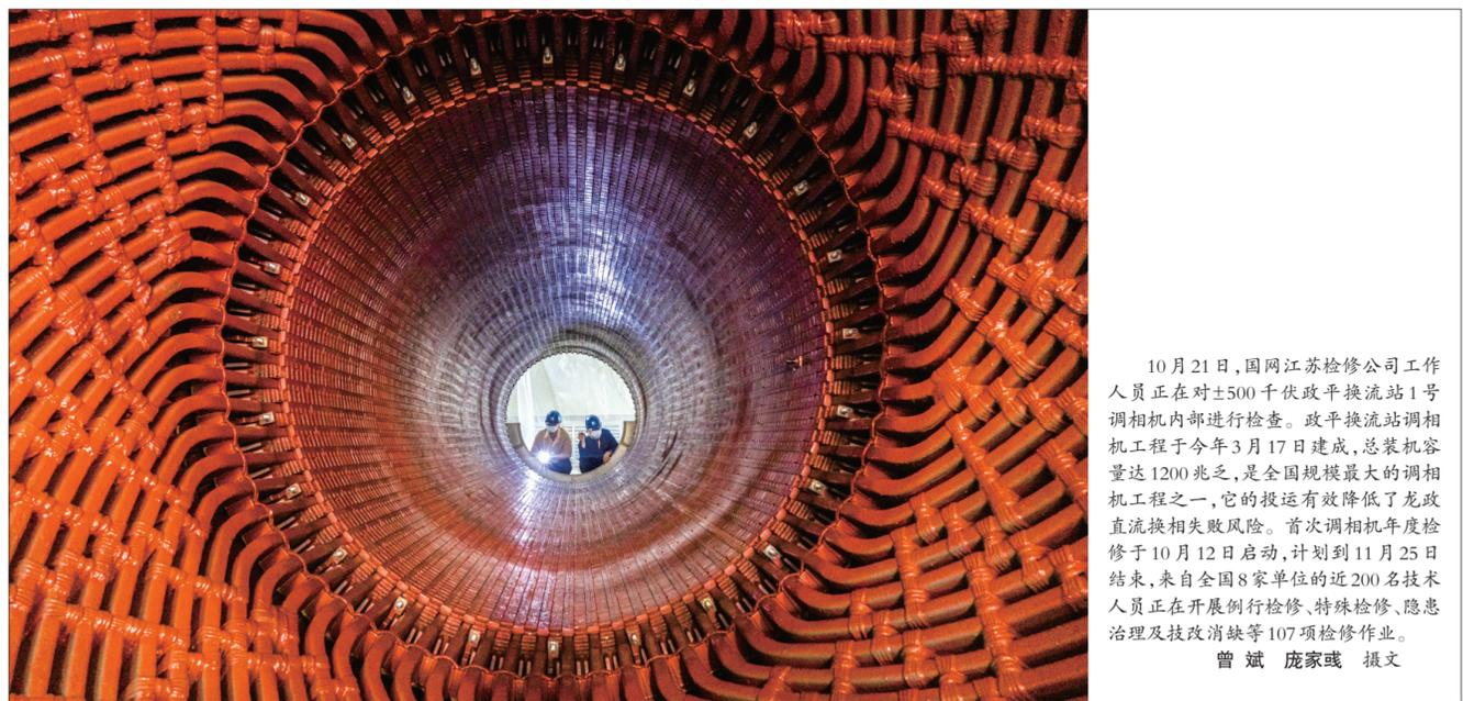
10月21日,国网江苏检修公司工作人员正在对±500千伏政平换流站1号调相机内部进行检查。政平换流站调相机工程于今年3月17日建成,总装机容量达1200兆瓦,是全国规模最大的调相机工程之一,它的投运有效降低了龙政直流换相失败风险。首次调相机年度检修于10月12日启动,计划到11月25日结束,来自全国8家单位的近200名技术人员正在开展例行检修、特殊检修、隐患排查及技改消缺等107项检修作业。
