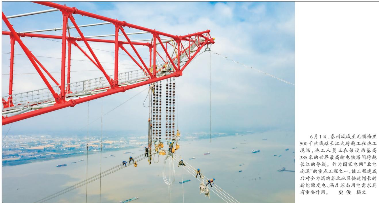
6月1日,泰州凤城至无锡梅里500千伏线路长江大跨越工程施工现场,施工人员正在架设两基高385米的世界最高输电铁塔间跨越长江的导线。作为国家电网“北电南送”的重点工程之一,该工程建成后对全力消纳苏北地区快速增长的新能源发电、满足苏南用电需求具有重要作用。 史俊 撰文
