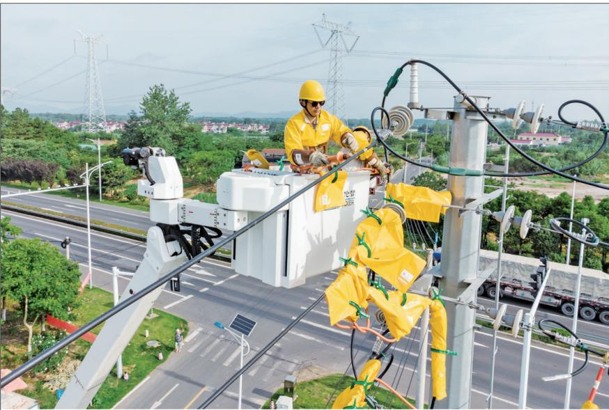
7月4日,国网南京市溧水区供电公司工作人员正在将10千伏溧水线西站支线上的部分负荷转移至溧洪联络线,以满足该村养殖用电需求。图为带电作业人员正在将10千伏溧水线西站支线上的部分负荷转移至溧洪联络线。
