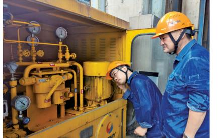
7月19日,江苏华电扬州发电有限公司工会锅炉分公司组织开展“迎峰度夏巡回检查”劳动竞赛,通过赛巡查流程规范、赛巡查质量、赛作风形象,进一步提高及时发现处置高温时段易发故障设备的能力。图为参赛选手正在察听6号磨煤机油泵站转动轴承运转情况。夏元明 陈军 撰文
