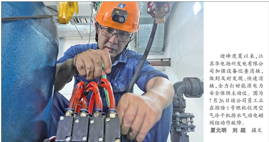
迎峰度夏以来,江苏华电扬州发电有限公司加强设备巡查消缺,做到及时发现、快速消缺,全力打好能源电力安全保供主动仗。图为7月26日该公司员工正在排除1号燃机用空气冷干机排水气动电磁阀组动作故障。夏元明 刘超 摄文
