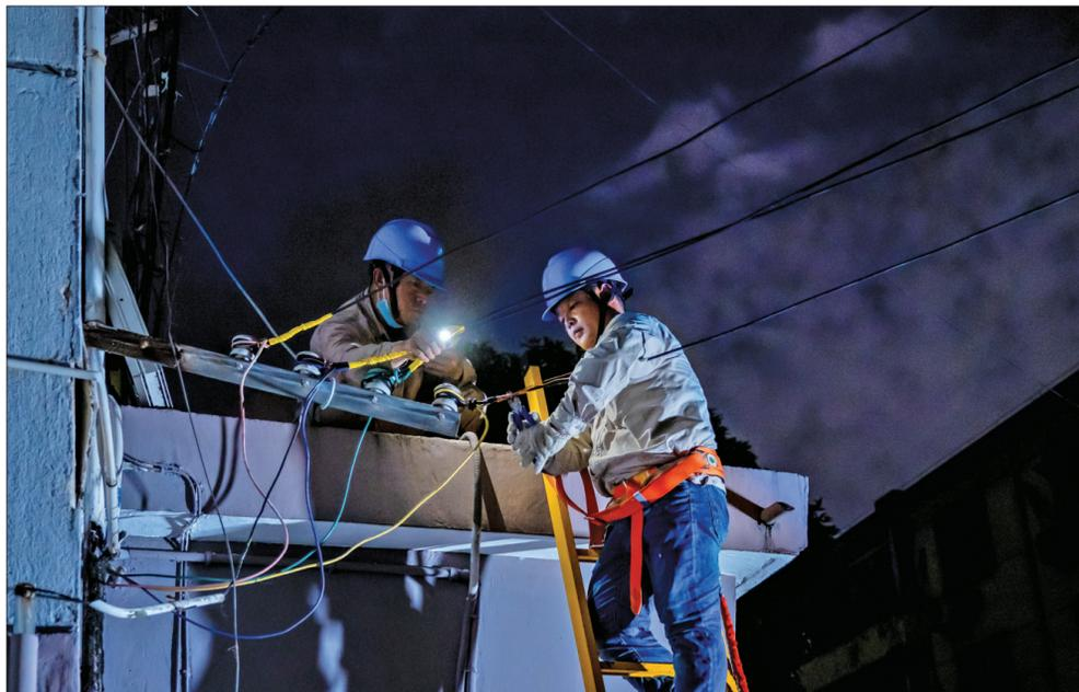
7月26日下午,苏州市部分地区突遭雷暴大风天气袭击,造成多条10千伏线路故障停运。国网苏州供电公司迅速组织抢修,经过近7个小时连续奋战,于当天22时许全面恢复因雷暴天气导致的断电区域供电。图为当晚抢修人员正在姑苏区盘溪新村64号楼前更换被大风吹断的老旧接户线。 谢鹏 摄文
