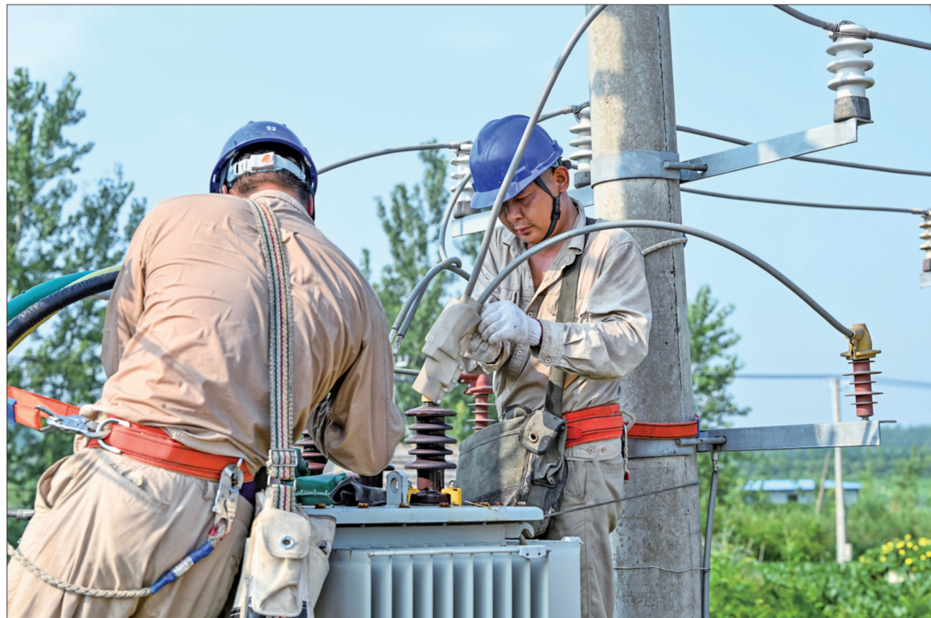
8月2日,国网金湖县供电公司监测发现徐涂镇泰庄村窑湾5号台区容量为200千伏安的配电变压器超载,随即组织将其更换为400千伏安的新配电变压器,满足该台区58户居民及8个养殖户的高温用电需求。图为施工人员正在安装新配变。梁德斌 韩能伟 撰文
