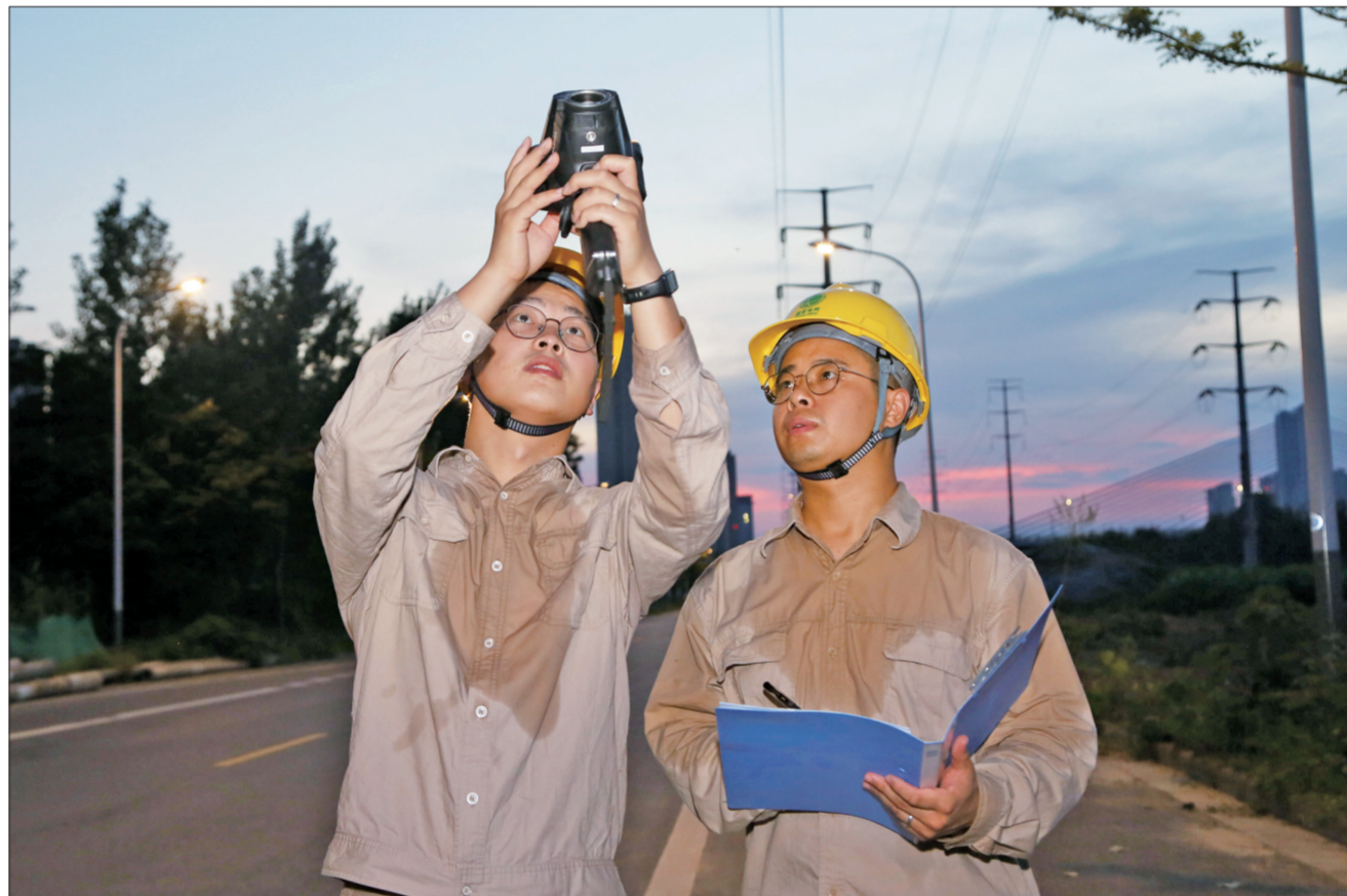
入夏以来，国网江苏省电力有限公司强化电网设备精益化运维，及时发现并处置隐患缺陷，确保江苏电网安全稳定运行。图为8月6日晚国网淮安供电公司员工正在对220千伏淮米、淮钱线进行特巡测温。 邵帅 摄文
