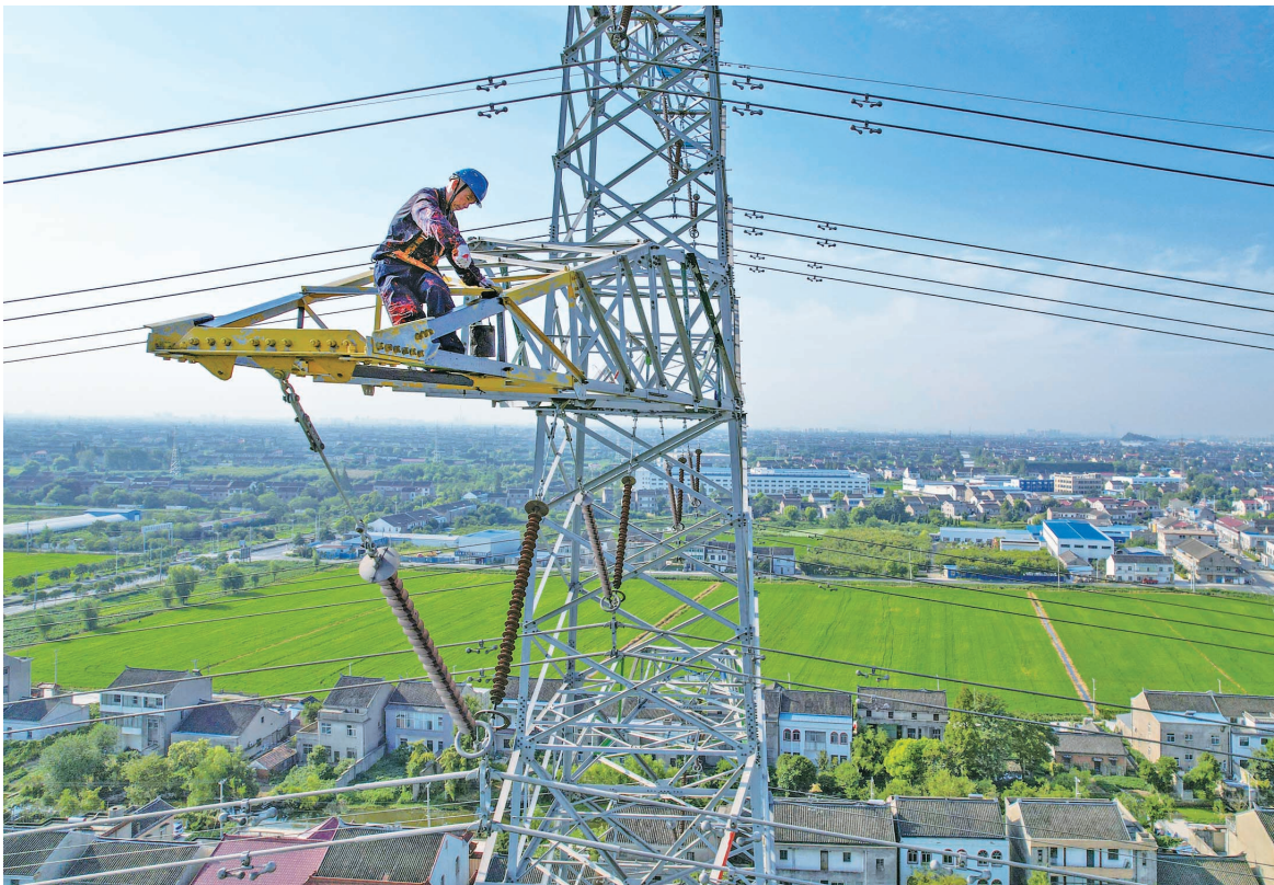
连日来,国网泰州供电公司组织对泰州境内2700多千米输电线路开展定期特巡,加强运维管理,提升供电可靠性。图为8月10日该公司员工正在姜堰市220千伏胜国线42号塔上刷防腐漆。 汤德宏 汪红浩 撰文
