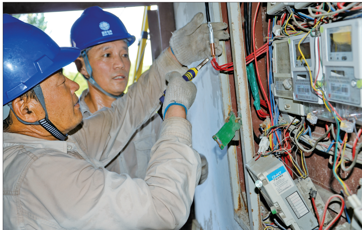
8月13日,徐州市铜山区气温高达37℃。柳泉供电所电工巡视发现柳泉镇富华小区1号楼2楼1单元集中表箱接线发热,总开关已有烧焦痕迹,便迅速开展抢修,仅45分钟就恢复了表箱下客户的用电。因为两位电工正在紧张抢修中。 王庆标 摄文
