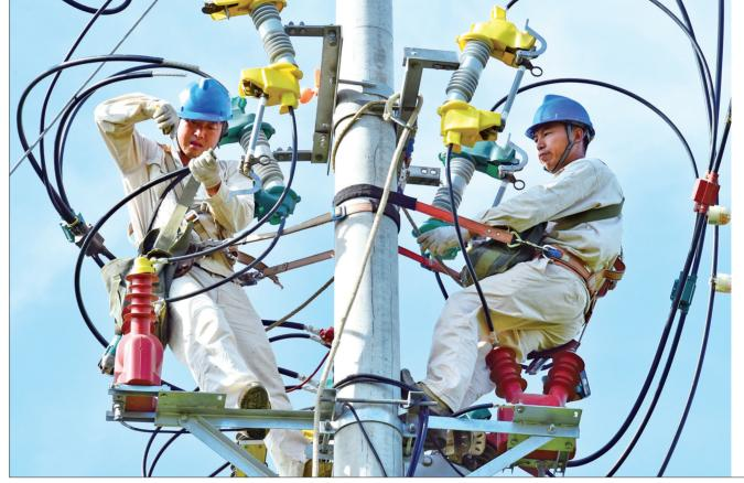
8月25日,国网盱眙县供电公司组 织对农业灌溉供用电设备开展特巡时发 现,桂五镇10千伏桂北线孙湖支线1号 杆断路器C相桩头因接触不良出现打火 现象,随即将该线路用电负荷通过环网 供电方式转移至10千伏东风线,并及时 组织抢修,保障农户灌溉用电无虞。
