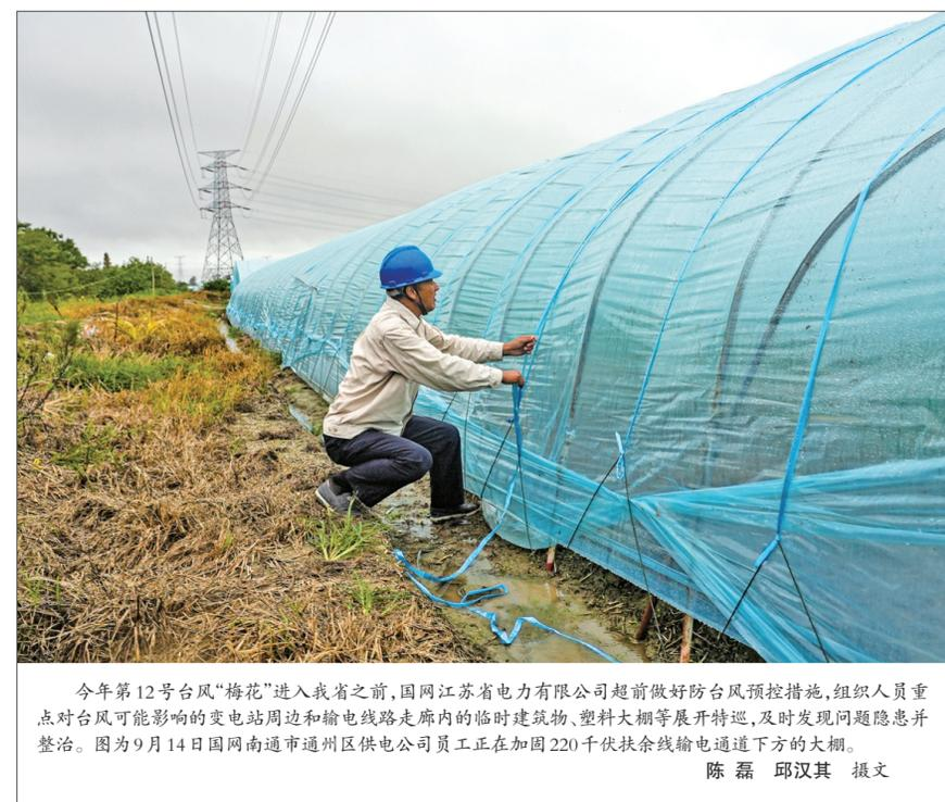
今年第12号台风“梅花”进入我省之前，国网江苏省电力有限公司超前做好防风防汛措施，组织人员重点对台风可能影响的变电站周边和输电线路走廊内的临时建筑物、塑料大棚等展开特巡，及时发现隐患并整治。图为9月14日国网南通市通州区供电公司员工正在加固220千伏扶余线输电通道下方的大棚。
