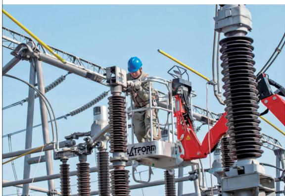
▲ 12月8日傍晚,国网泰州供电公司输电运检中心带电作业班驰援南通,通过带电作业方式完成了220千伏蓬溪线4号塔中相引流线脱落的抢修作业,确保如东海上风电安全并网送出。
