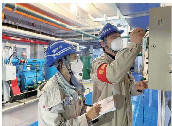
▲ 12月23日,国网张家港供电公司输变电运检人员来到110千伏城东变电站,更换了站内运行年限较长的部分线路保护测控装置,以此确保设备安全稳定运行。朱萍 摄文
