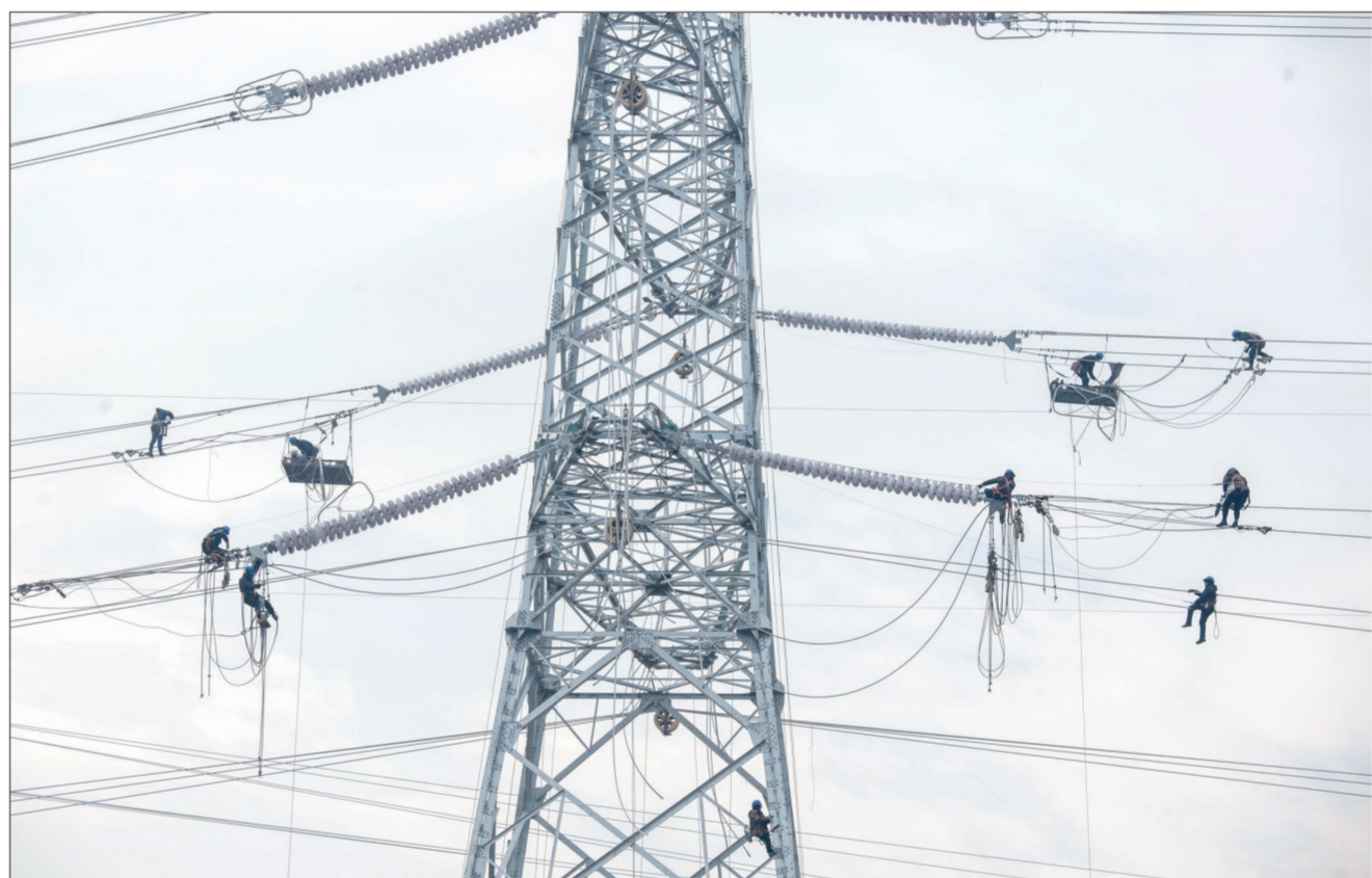
1月1日，在江阴市徐霞客镇500千伏线路迁移改造现场，施工人员正在80多米高空架设线路。为了配合霞客湾科学城规划发展，需对500千伏泰斗等线路进行迁移、新建杆塔32基及线路12.5千米。2023年第一天，徐州送变电有限公司150多名施工人员坚守岗位，冒严寒紧张作业，确保工程4月如期竣工。 潘正光 撰文
