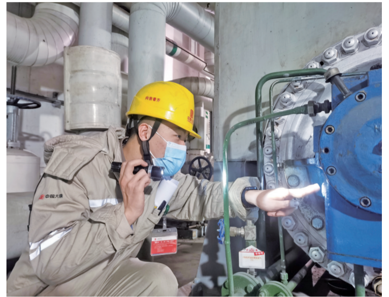
1月22日,大年初一,大唐南京电厂单机运行期间,运行人员正在认真检查前置泵的油位是否符合要求。 朱施琼 摄
