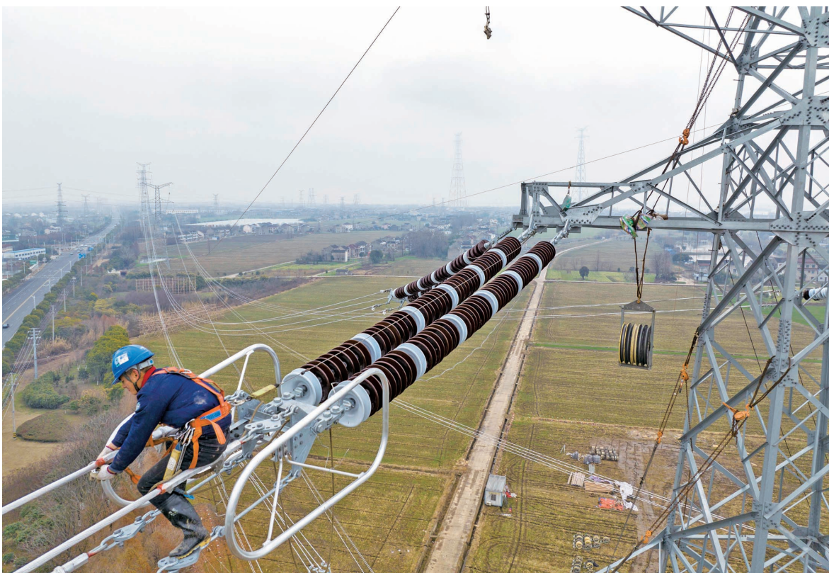
2月7日,泰州凤城至无锡梅里500千伏线路跨越500千伏泰斗、兴斗线施工现场,施工人员正在高空施放导线。凤城至梅里输电线路工程是江苏电网“北电南送”重点工程之一,也是我省第六个穿越长江的高等级电力通道。目前,该工程已进入最后冲刺阶段,2月底将具备带电条件。 汤德宏 王伟 摄文
