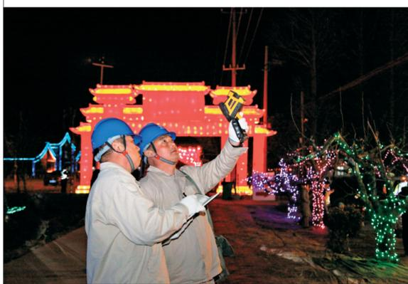
2月5日是元宵节，国网新沂市供电公司组织所属各农村供电所电工到马陵山景区、窑湾古镇等花灯节现场，检查电力线路和设备运行情况，保障花灯节用电安全可靠。图为当日马陵山供电所电工正在马陵山景区花灯节现场用红外测温设备检查景区专线运行情况。 韦强强 刘素素 摄文
