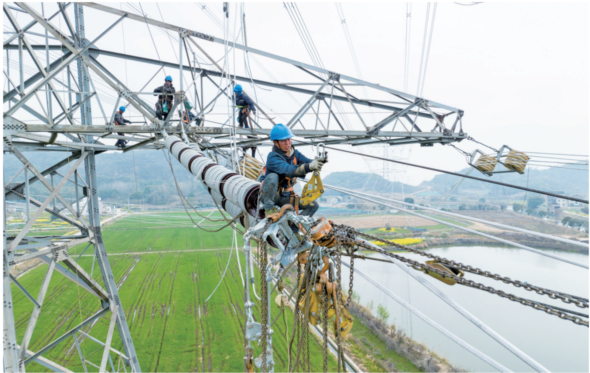
▲ 3月20日,电力工人正在泰州凤城一无锡梅里500千伏输电线路工程江南段开展导线附件安装作业。该工程江南段是江苏电网2023年迎峰度夏工程,全长79.5千米,计划今年6月全线贯通,投运后可有效改变江苏南北电源分布不均带来的“北电南送”能力不足的状况。王雨萌 董小强 摄文 ▲ 3月20日,国网南京供电公司组织对南京市溧水区220千伏渔歌变电站2号主变压器实施检修,消除设备缺陷,保障电力安全稳定供应。杜懿 束佳玲 摄文
