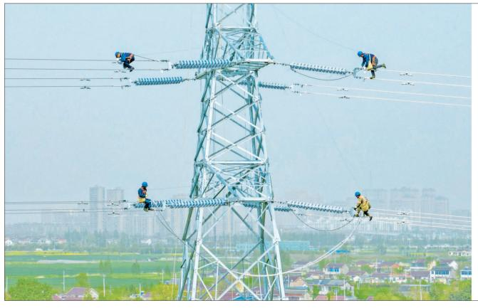
4月12日,江苏安泰输变电工程有 220千伏白杨输变电工程线路架设高空 作业。连日来,该公司加紧推进工程建 设,确保5月投产,为地方经济社会高质 量发展提供电力支撑。
