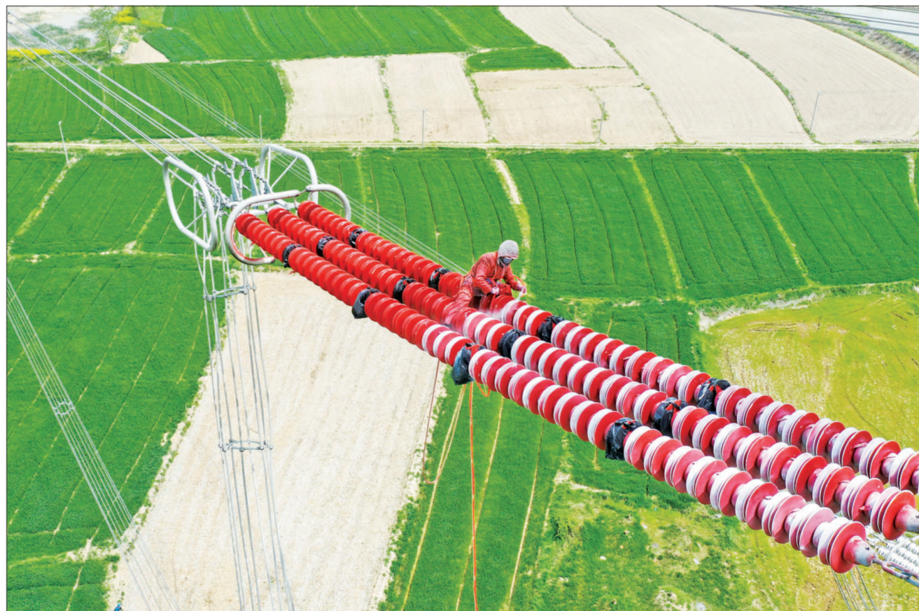
4月13日，1000千伏特高压盱眙Ⅱ线春季检修现场，江苏省送变电有限公司员工正在百米高空为绝缘子喷涂防腐闪涂料。连日来，该公司在加强输电线路高空作业人身安全的前提下，有序排查并消除缺陷，确保夏季用电高峰时线路安全稳定运行。 史俊 摄文
