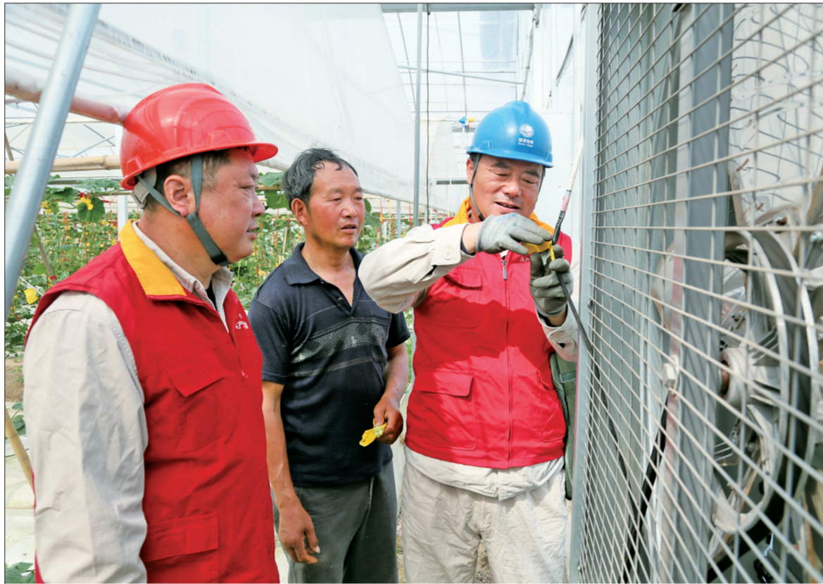
东台市许河镇种植冬瓜已有500多年历史,目前全镇种植面积已突破3万亩。4月18日,该市许河供电所“盐电铁军·金海星”共产党员服务队队员来到许河镇现代农业园,帮助冬瓜种植户检查大棚内的供电线路和排风、施肥、灌水等用电设备。图为检查人员正在绑扎破皮的电线以消除安全用电隐患。孙永兴 段学慧 摄文
