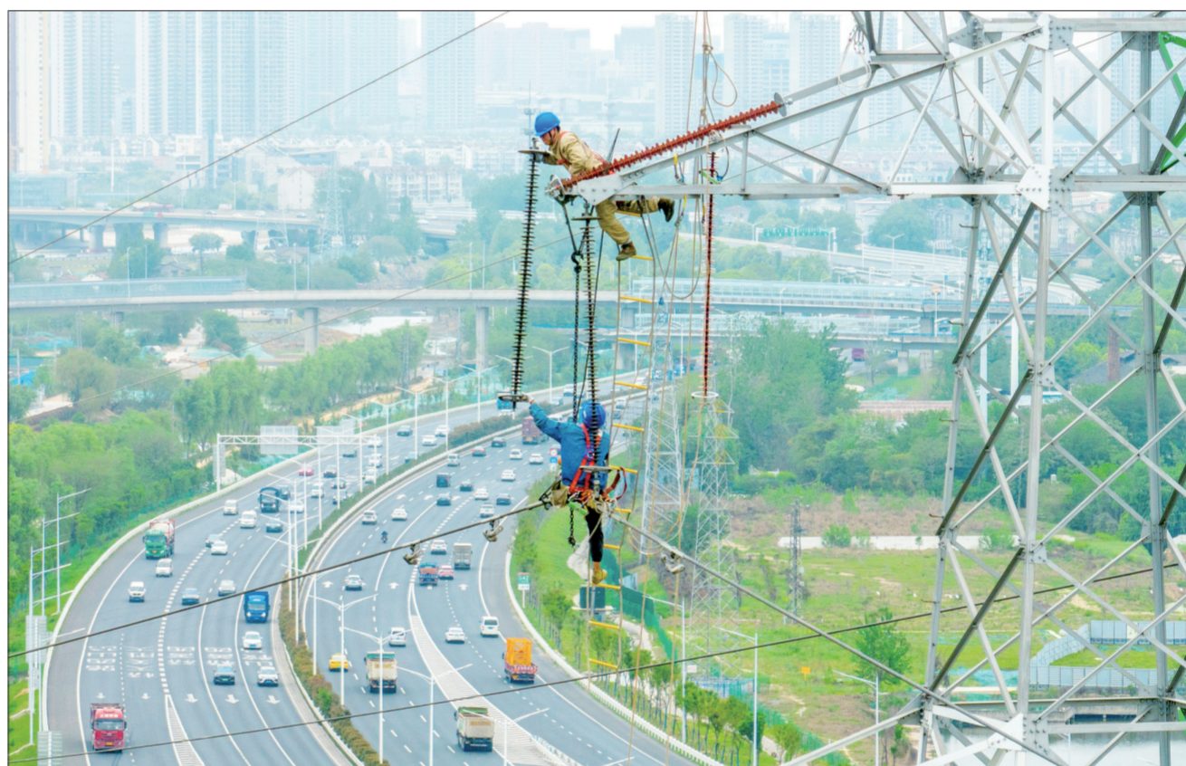
4月21日，国网南京供电公司组织对220千伏泰滨线进行综合检修，开展零值绝缘子检测、X光探伤检测并更换存在缺陷隐患的绝缘子等，为迎峰度夏做好准备。杜懿 撰文
