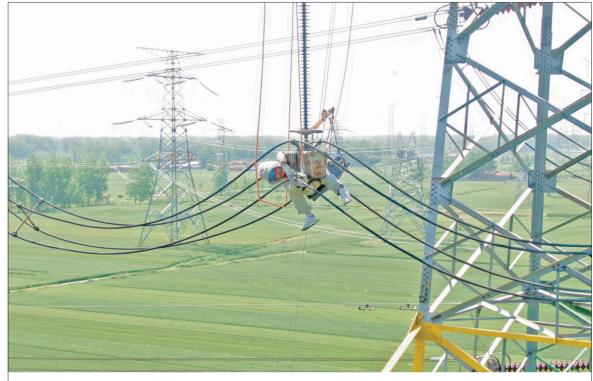
5月6日,国网宿迁供电公司与国网江苏超高压公司联合采取带电作业方式,消除了500千伏泗上线70号塔一子导线线夹螺栓缺销子等两处危急缺陷,避免了导线脱落引发线路跳闸事故的发生。**张海军 唐军** 摄文
