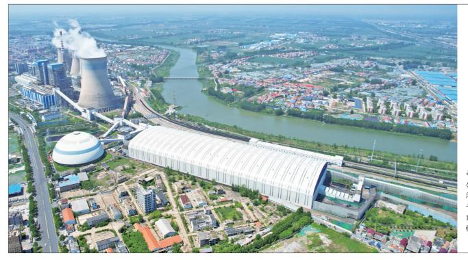
5月7日,俯瞰江苏新海发电有限公 司干煤大棚,白色的棚顶格外耀眼。该 公司近日完成对原有露天煤场的防尘封 闭改造。新建的干煤大棚总面积约5万 平方米,预计每年可减少颗粒物排放 133吨,减少雨季原煤损失3000余吨,大 幅度降低煤炭扬尘对周边环境的影响。
